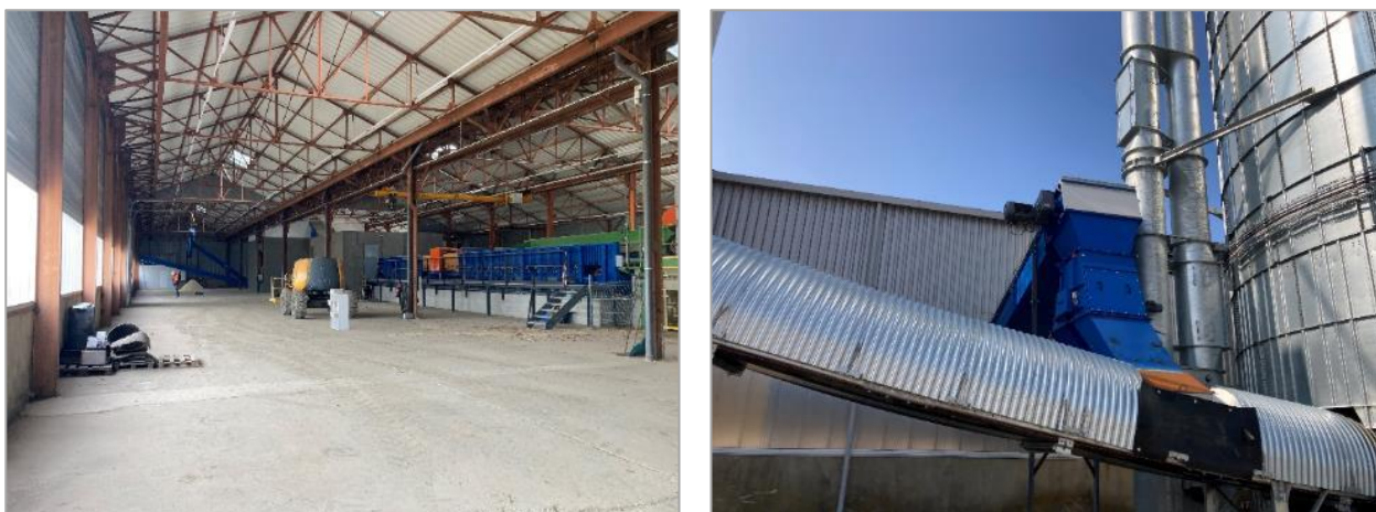
Figure 3 – Photographie de l'intérieur du hangar (à gauche), et du circuit d'éjection des granulés (à droite)
