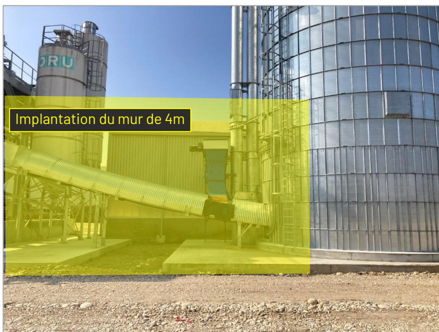
Figure 14 – Photographie de l'équipement extérieur d'extraction des granulés
