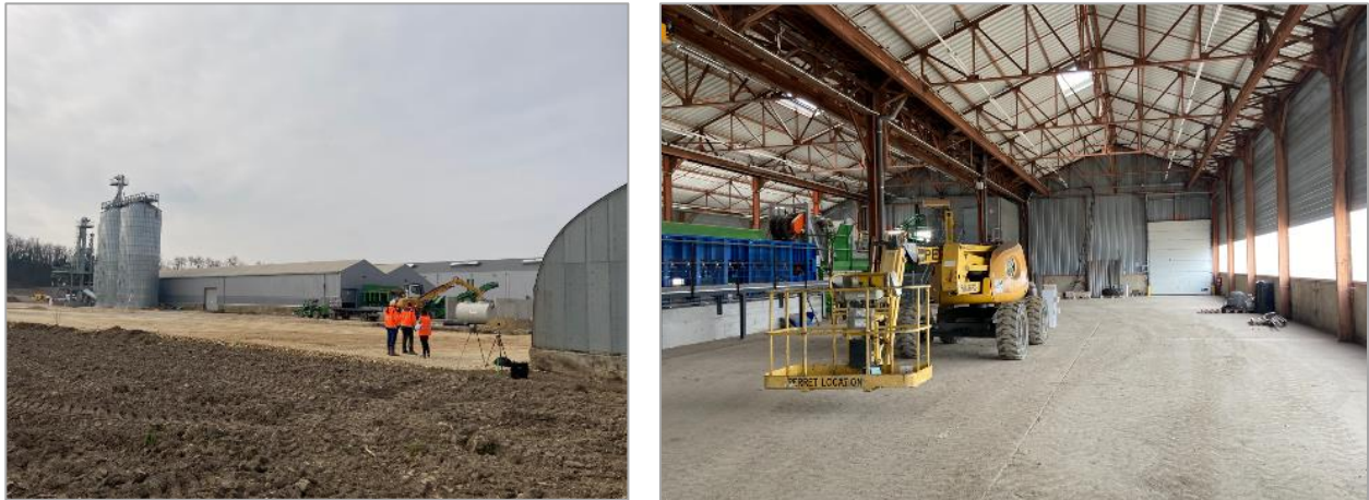
Figure 1 - Photos prises sur site avec extérieur et intérieur
